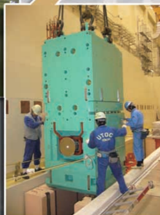
超高耐放射線電磁石 高エネルギーの陽子を標的に向かって撃ち込むための電磁石。陽子が放つ放射線を遮蔽するために鉄でおおわれています。
