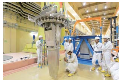
2017年9月に納品された 中性子発生標的8号機
