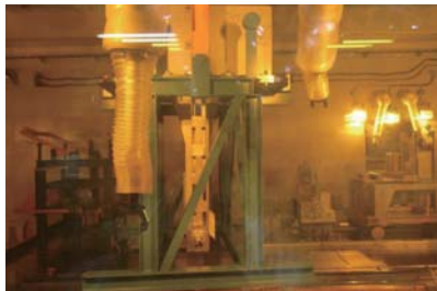
水銀標的容器保管容器の移動 (物質・生命科学実験施設)
