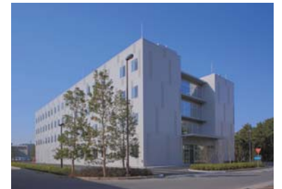
新しく建設されたJ-PARC研究棟(北東側から撮影)
