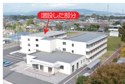
宿泊棟が増設された東海ドミトリー全景
