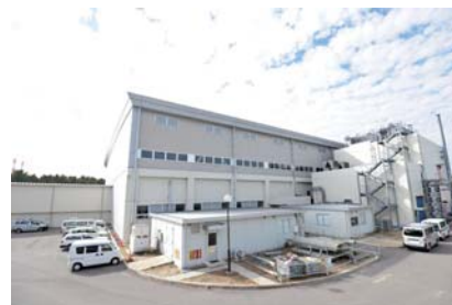
改修工事を進めているハドロン実験施設
