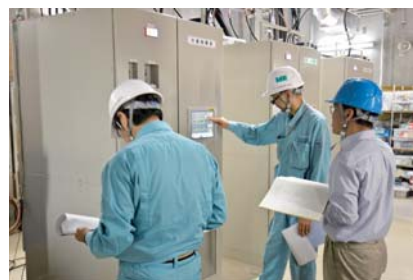
電磁石電源の実負荷通電試験 (ニュートリノ第1設備棟)
