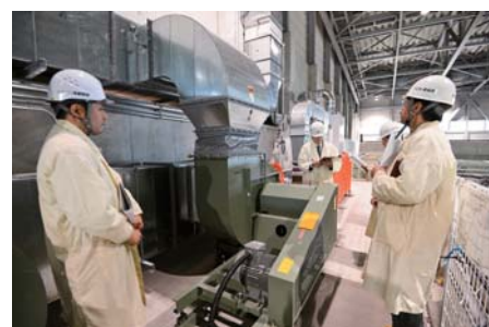
排気設備の性能確認(4/22)
