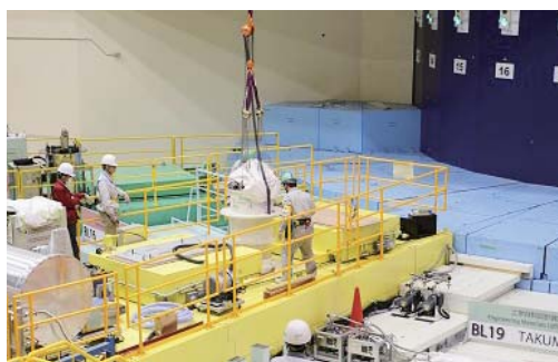
マグネットの据付作業を行うBL17(MLF)
