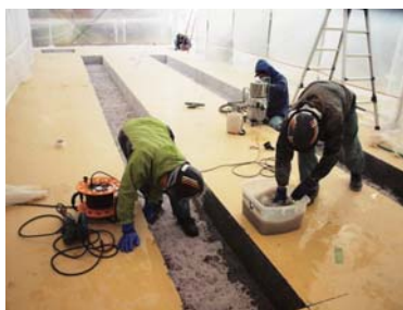
K1.1 ビームライン建設に向けた床工事 (ハドロン実験施設(実験ホール南側))
