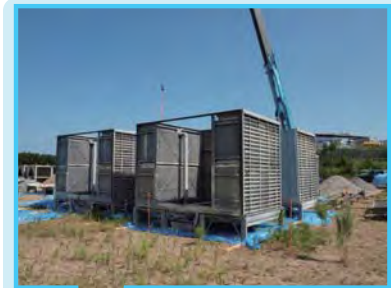
撤去された冷却塔。点検修理あるいは新品と交換。
