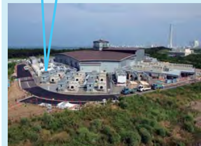
3GeV シンクロトロン周回道路の復旧。電源ヤード、冷却水設備の修復が本格化。
