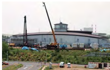
3GeVシンクロトロン周回道路の仮復旧（手前法面の崩落防止のため矢板打設工事）
