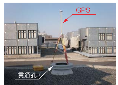
GPS測量作業 (3GeVシンクロトロン屋外電源ヤード)
