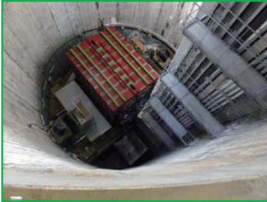
ニュートリノ前置検出器ピット内は、目立った被害は見受けられない。ピット最下階に5cm程度水がたまったが、排水。
